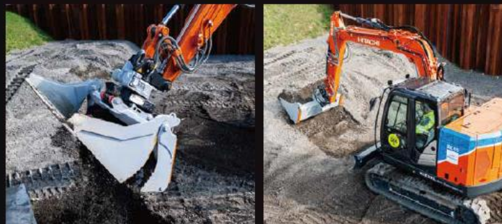
バケットによるローダー作業
